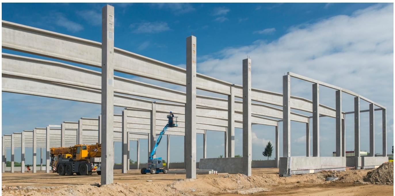
**“ Specialitou konstrukce jsou železobetonové nepředpjaté sedlové střešní vazníky průřezu „I“ s výškou ve vrcholu 1,6 m a délkom 30 m. ”**
