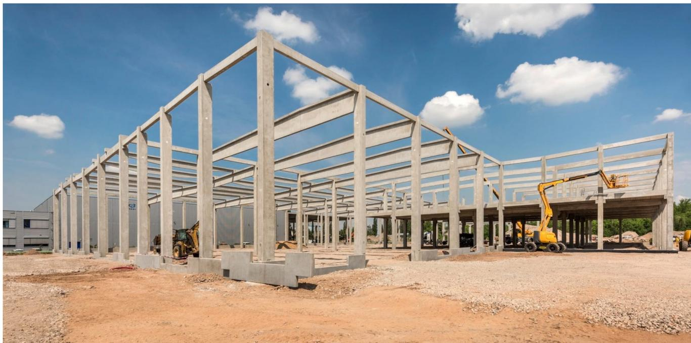
“ Provedli jsme přeprojektování původního návrhu ocelové konstrukce administrativní části a nahradili ho prefabrikovaným železobetonovým řešením. ”
